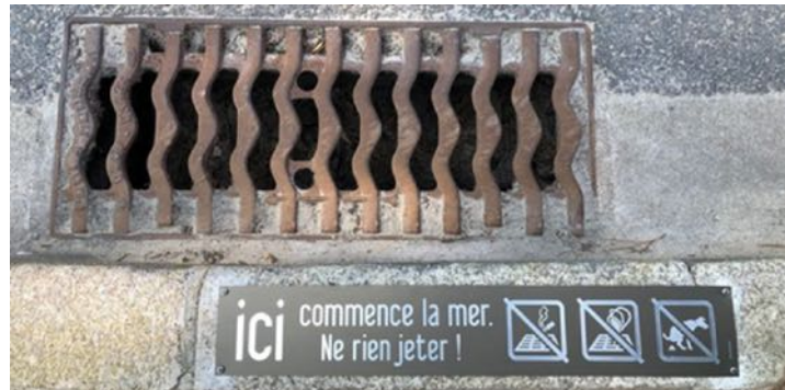
Figure 29 : Message de prévention anti-rejet des déchets sur une plaque d'égout
