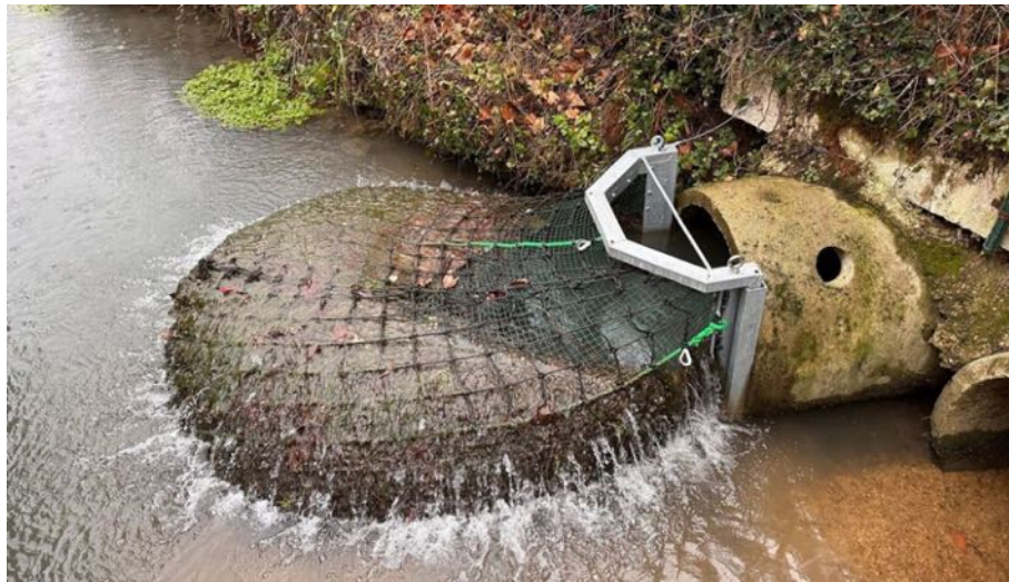
Figure 30 : Exemple de filet mis en place par Pollustock à un exutoire d'eau usée
